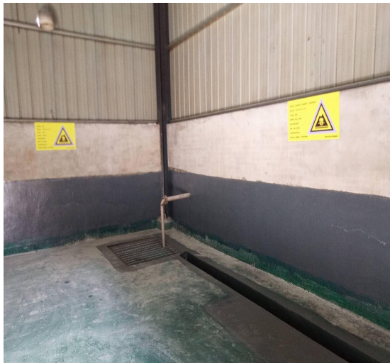
危废仓库导流沟渠
