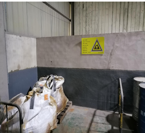
危废仓库防渗漏托盘
